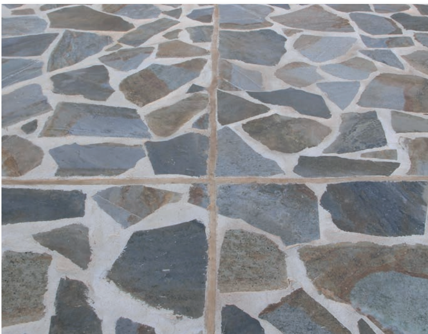
Δημιουργία αρμού διαστολής σε επιφάνεια ταράτσας επενδυμένης με πλάκες Καρύστου.
