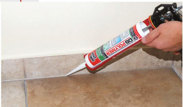
Σφράγιση-πλήρωση αρμών τοιχοποιίας σε συνάντησή του με κάσωμα (ξύλινο, αλουμινένιο, μεταλλικό). Το υλικό προσφύεται άφογα σε πορώδη επιφάνεια χωρίς αστάρι.
