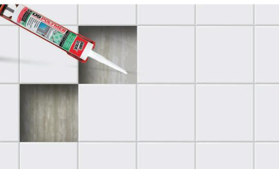
Ασφαλής επανατοποθέτηση (συγκόλληση-αρμολόγηση) αποκολλημένου στοιχείου επένδυσης.
